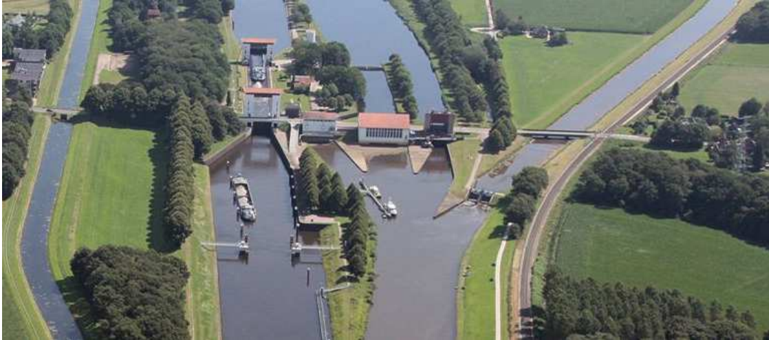
Sluis Eefde [Rijkswaterstaat]
