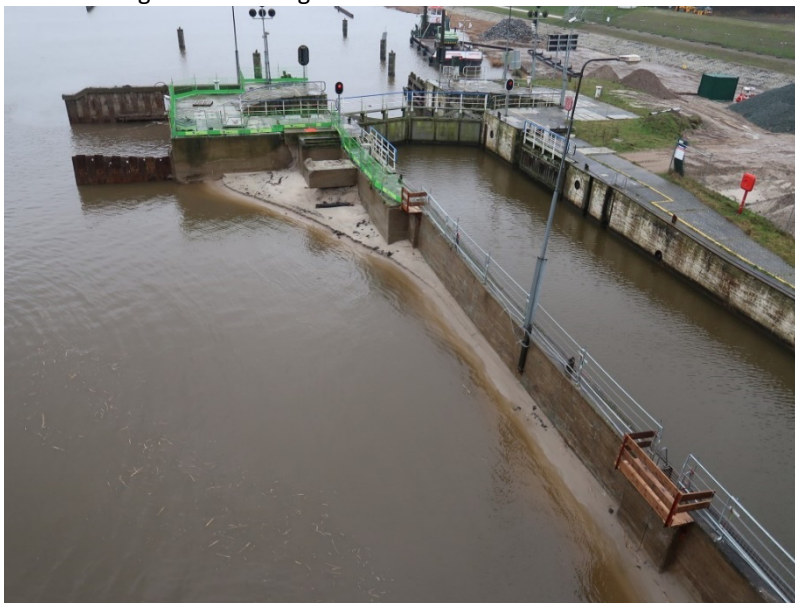
Foto 1: Bovenaanzicht van de sluis kolk en het noordelijke landhoofd
