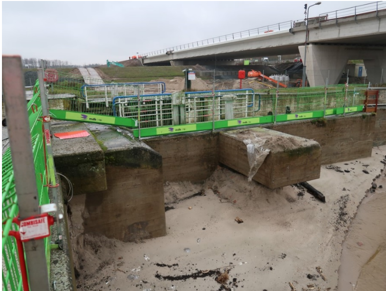
Foto 6: Achterzijde van de wand van het noordelijke landhoofd
