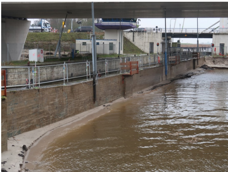
Foto 7: Achterzijde van de kolkwand
