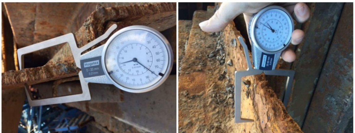
Figuur 2.17 Diktemeting zoals uitgevoerd bij damwanden Hollandsche IJsselkering. Bron: DeKlerk Staalconstructie, 2016.
