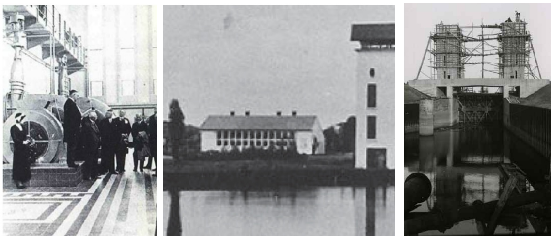
Figuur 2.7 Rechts: benedenhoofd schutsluis Eefde in aanbouw, damwanden waren al aanwezig (foto medio 1932) [Bierman 2011]. Midden en Links: opening op 1 juli 1933 [Bierman 2011]
