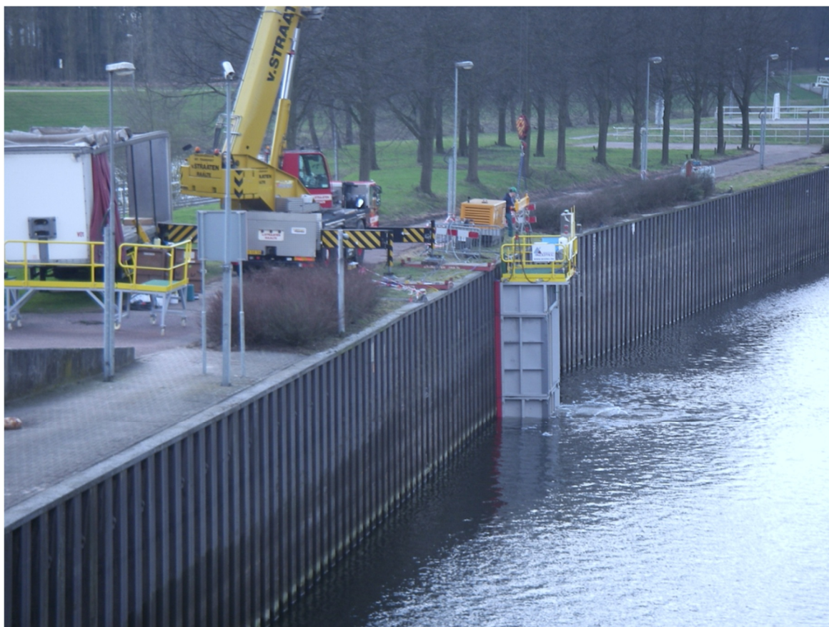
Figuur 2.5 Inzet van DroogZetInstalatie (DZI) bij Eefde waar binnen de metingen in 2012 zijn uitgevoerd [KpNK 2018]
