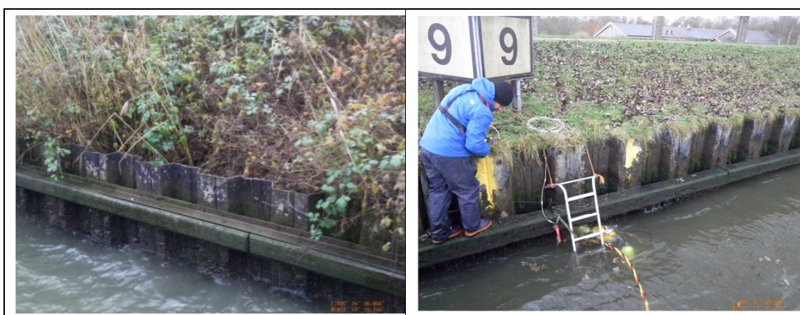
Figuur 2.18 Links : Principe damwandconstructie Amsterdam-Rijnkanaal. Rechts duikinspectie. [DHV 2012a].
